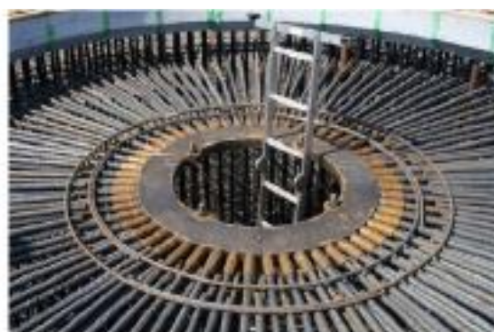
Рисунок 15: Армирование верхней зоны.
