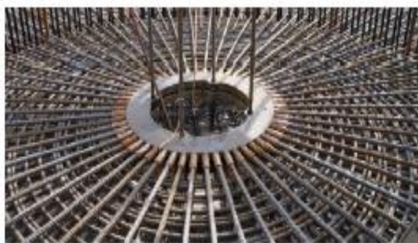
Рисунок 14: Армирование нижней зоны.
