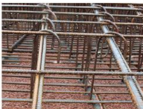
Рисунок 16: Армирование стенки.
